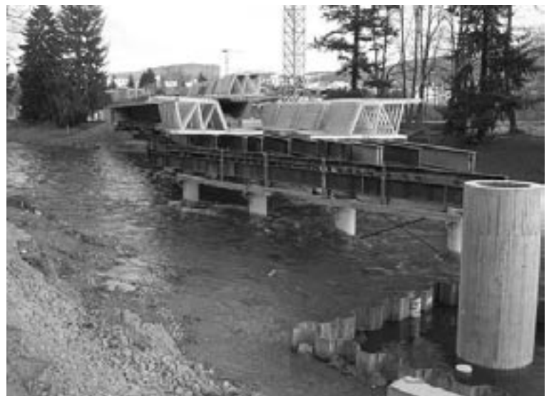
Stand der Bauarbeiten bei der Zollfreien. Photo Kristian Persohn
